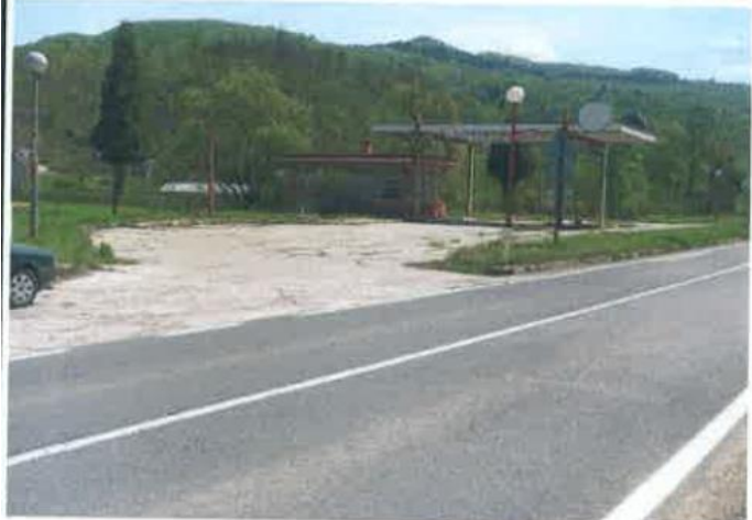
Magistralna cesta M-5 prilaz objektu pogled iz pravca Lašve
